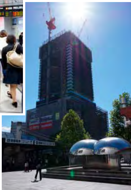
駅前で建設中のシティタワー広島
